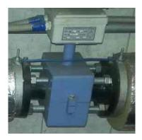
На первичнике обычно наносится стрелка направления потока, однако находятся "пионеры с большим опытом работы", которые обязательно монтируют первичник против потока.
